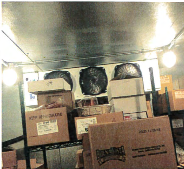
Evaporator Fan Unit
